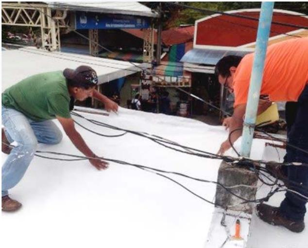
Foto: Subdirección Técnica Administrativa. Reparación y mantenimiento de loza en el área de terraza y techo, así como aplicación de impermeabilizante en la Delegación Migratoria de La Mesilla, Huehuetenango.
