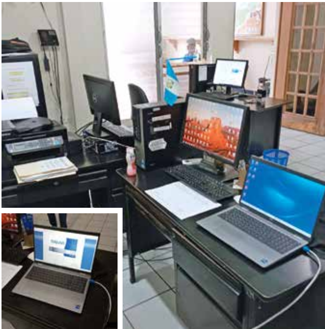
Foto: Subdirección de Recursos Tecnológicos. Instalación nuevo equipo aeródromo, Puerto Barrios.
