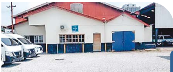
Centro de Atención y Registro de migrantes (CAR) ubicado en las instalaciones de Ferrocarriles de Guatemala.
